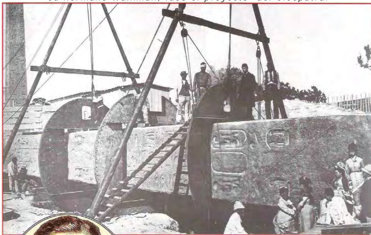
Una fase de las complejas operaciones llevadas a cabo para colocar la Aguja en estructuras de hierro a cuyo alrededor se construyó el Cleopatra
